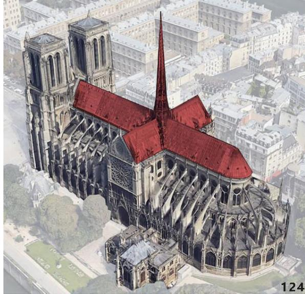
圖 124 巴黎聖母院鳥瞰圖，顯示建築的飛扶壁結構。
