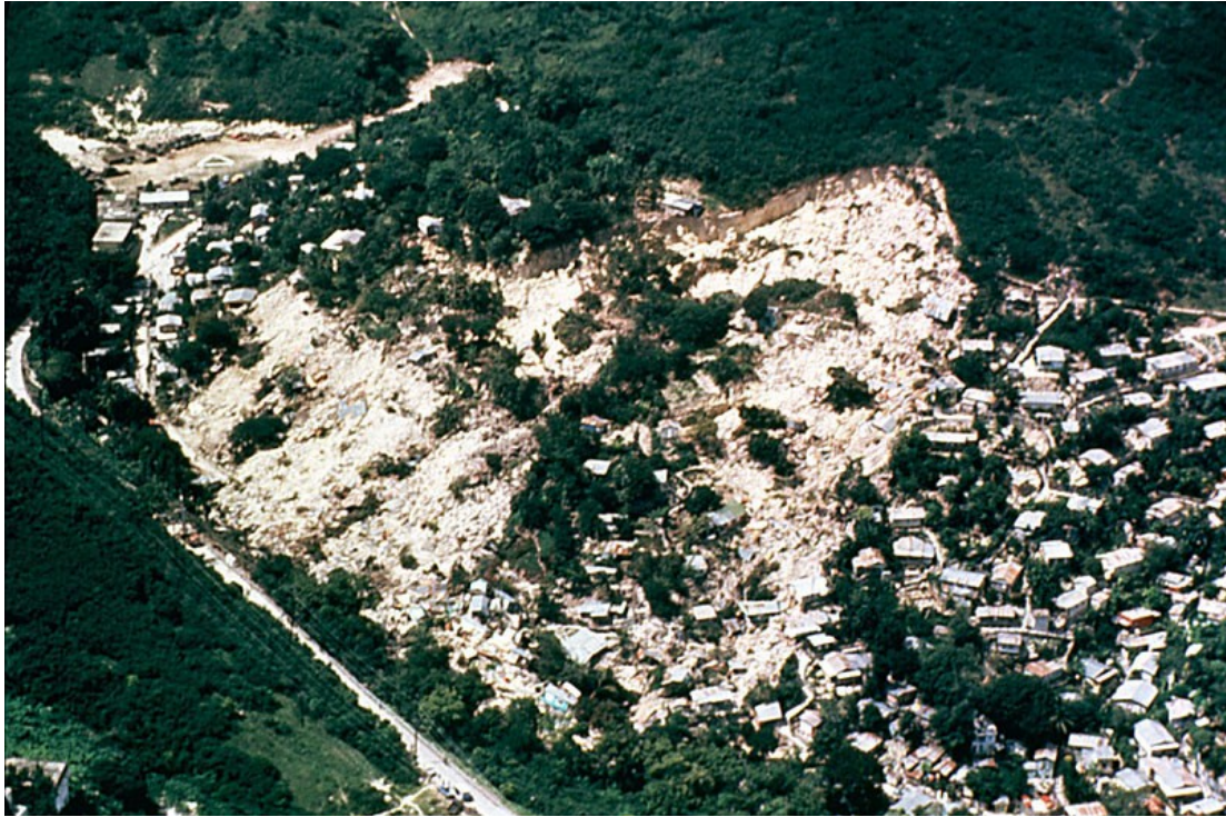
圖 2.波多黎各龐塞的巴里奧提貝斯市的 Mameyes 泥石流災害是由 1985 年熱帶風暴伊莎貝爾造成的大雨造成的。泥石流摧毀了 100 多個房屋，並造成了 300 人的生命。
