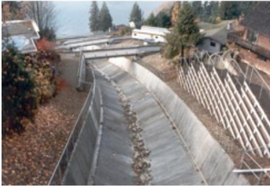
圖 6.緩解海天公路上泥石流的兩種策略。左：艾伯塔省克里克（Alberta Creek）上的混凝土襯砌通道使殘骸迅速流向海洋。右：查爾斯河上的泥石流集水盆地。2010 年，泥石流將盆地填滿，達到了白色虛線水平。[SE]
