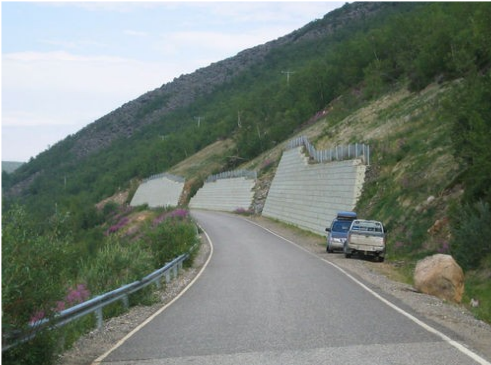
圖 9.一塊石牆穩定了已被切掉以形成道路的斜坡。
