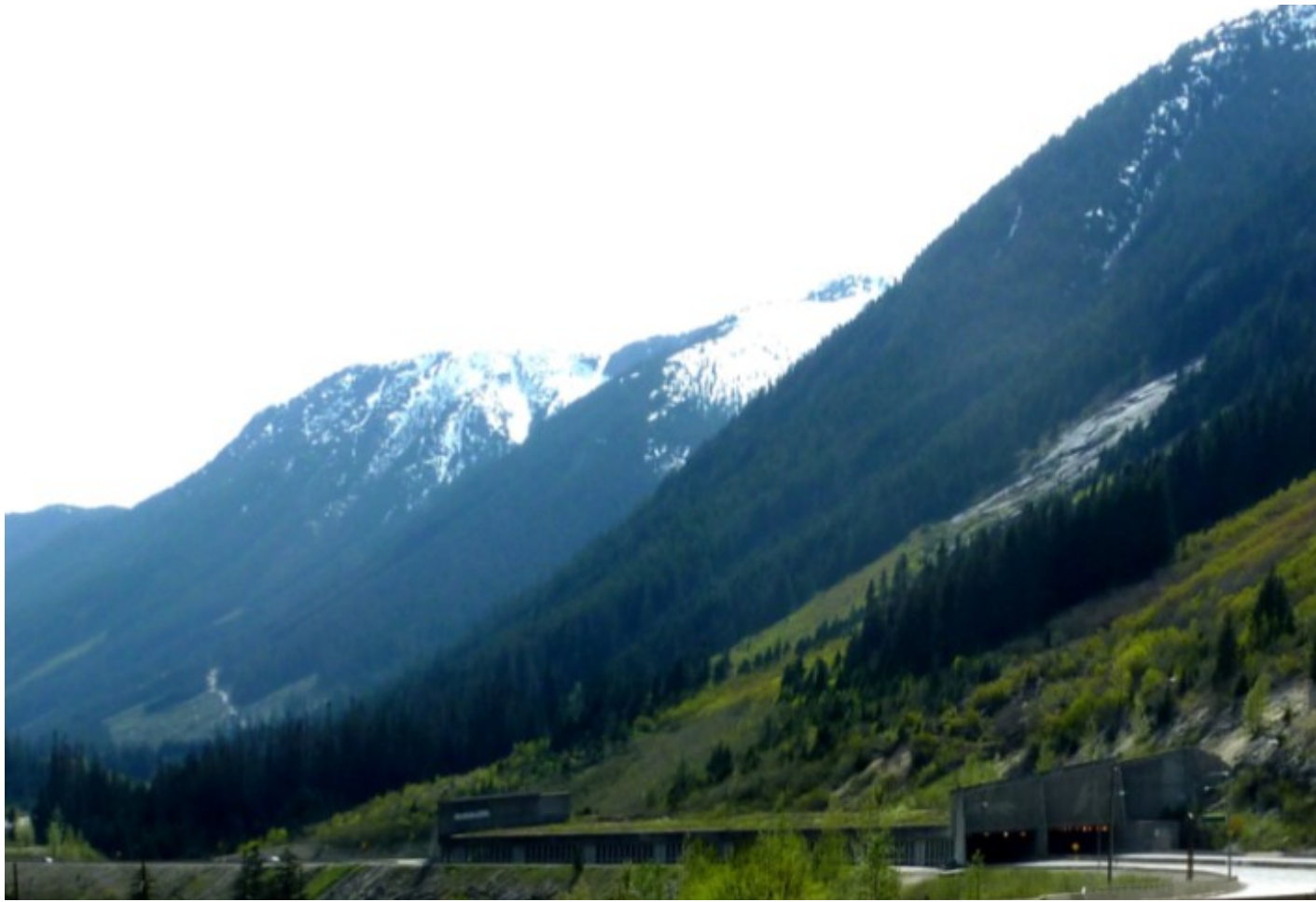
圖 5. Coquihalla 公路上的雪崩防護棚。雪崩的預期路徑是上方陡峭的未處理坡度。[SE]
