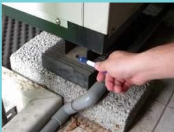
加裝隔振橡膠墊
