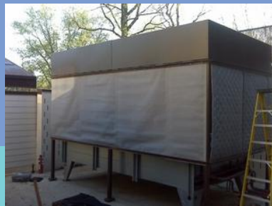
導風罩外側減速機馬達軟質防音罩設置示意圖
