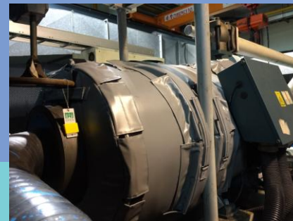
導風罩內側減速機軟質防音罩設置示意圖
