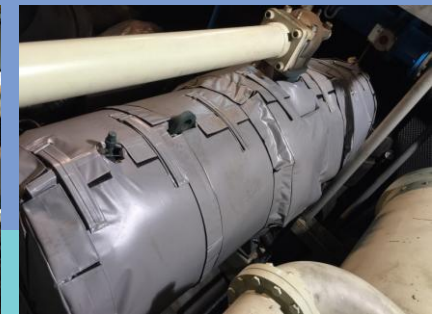
導風罩內側減速機軟質防音罩設置示意圖
