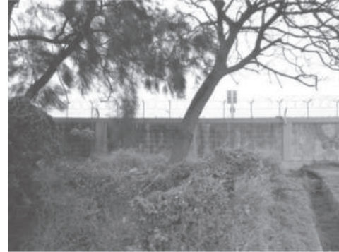
僅有周界圍牆與外界隔離
