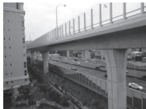
國 1 及五楊之隔音牆全景
