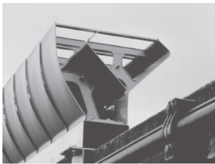
圖2.3-16 第二東名高速公路應用的變形 Y 型隔音牆
