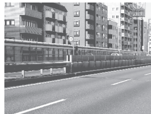
日本京都高速公路 (吸音筒)
