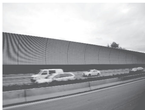
德國慕尼黑高速公路吸音隔音牆
