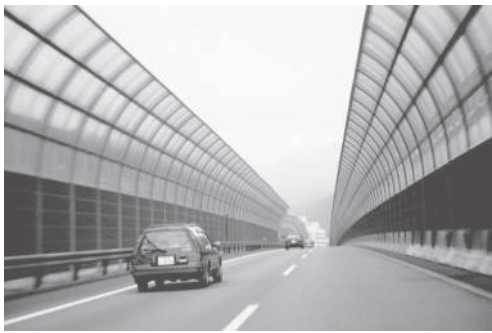
圖 2.3-7 日本半密閉型隔音牆
