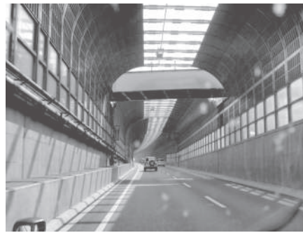
圖 2.3-8 日本全密閉型隔音牆
