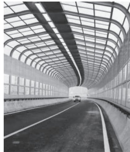
圖 2.3-26 石門山隧道(封閉式)隔音牆
