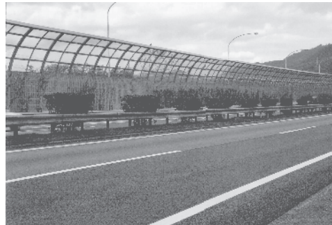
日本高速公路透光型 + 吸音隔音牆
