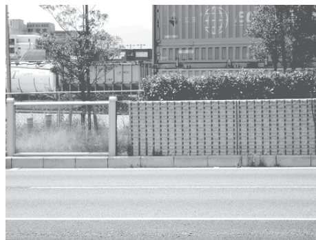
日本金屬共鳴吸音式低層隔音牆
