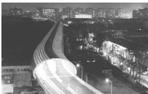
圖 2.3-25 北京動物園的隧道（封閉）式隔音牆
