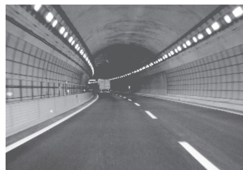
日本隧道內二側吸音隔音牆
