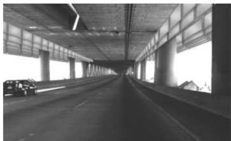
圖2.6-4 華盛頓州 I-5 船渠橋吸音材質鋪設照片
