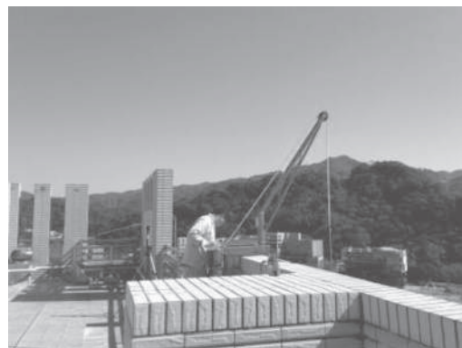
圖 11.1-9 夾牆架 - 吊掛作業
