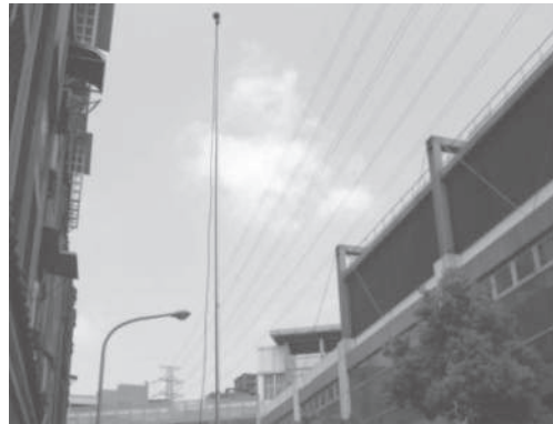
圖 11.1-7 高空車 - 高架作業
