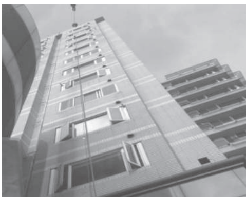
圖 11.1-8 吊車 - 吊掛作業
