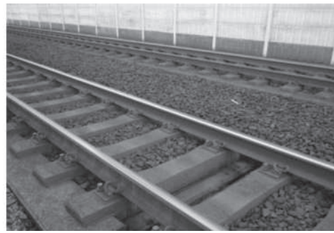
長焊鋼軌及撒佈吸音石碴
