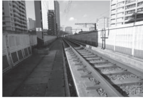
1.8 m 高護欄之內側設置吸音板
