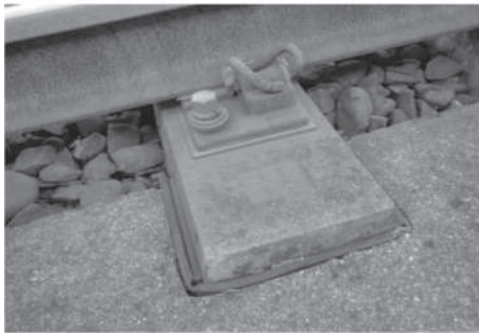
軌枕底部及端部安裝彈性材料
