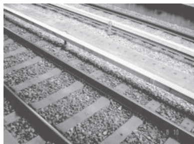
圖 3.3-8 以碎石構成的道床示意圖
