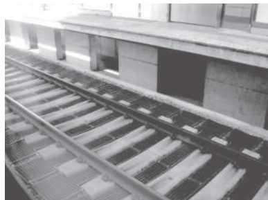
圖 3.3-9 軌道道床噪音防制示意圖
