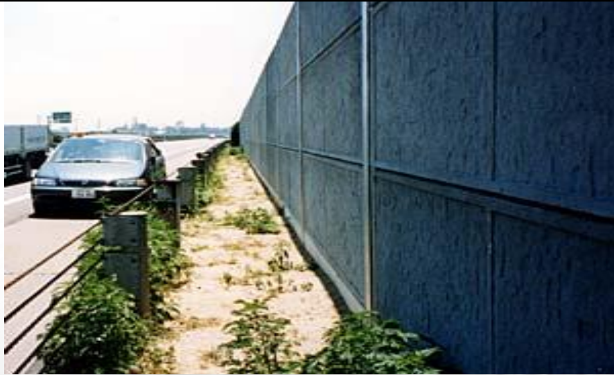
Kazo Expressway, Tokyo, 大塊混凝土牆
