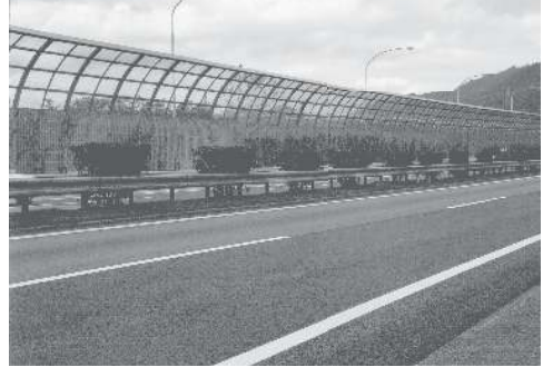
日本高速公路透光型+吸音隔音牆
