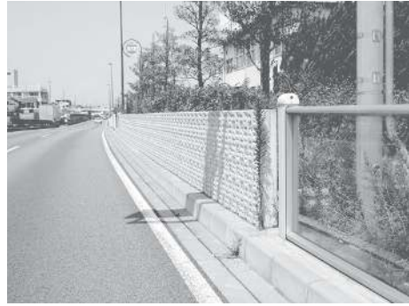
日本混凝土吸音式低層隔音牆
