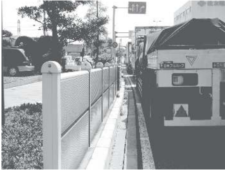
日本金屬吸音式低層隔音牆
