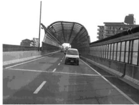
日本阪神高速公路（神戶線）隔音罩
