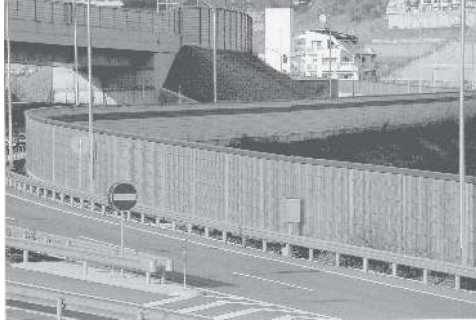
日本高速公路支柱隱蔽型吸音隔音牆
