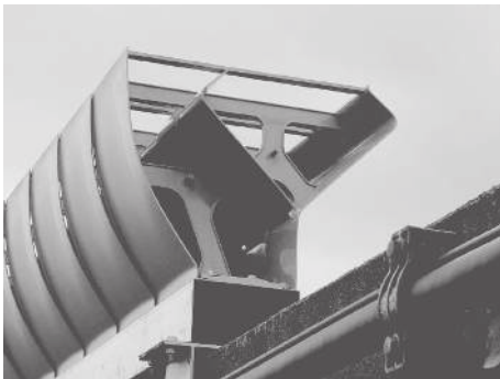
圖 2.3-16 第二東名高速公路應用的變形 Y 型隔音牆
