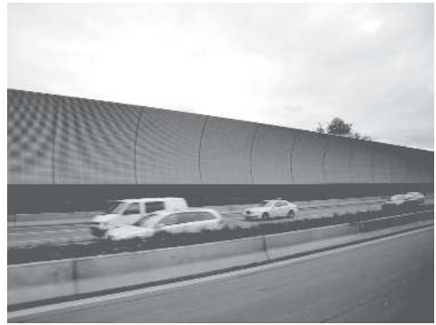
德國慕尼黑高速公路吸音隔音牆
