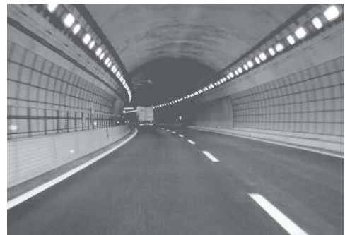
日本隧道內二側吸音隔音牆
