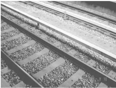
圖 3.3-8 以碎石構成的道床示意圖
