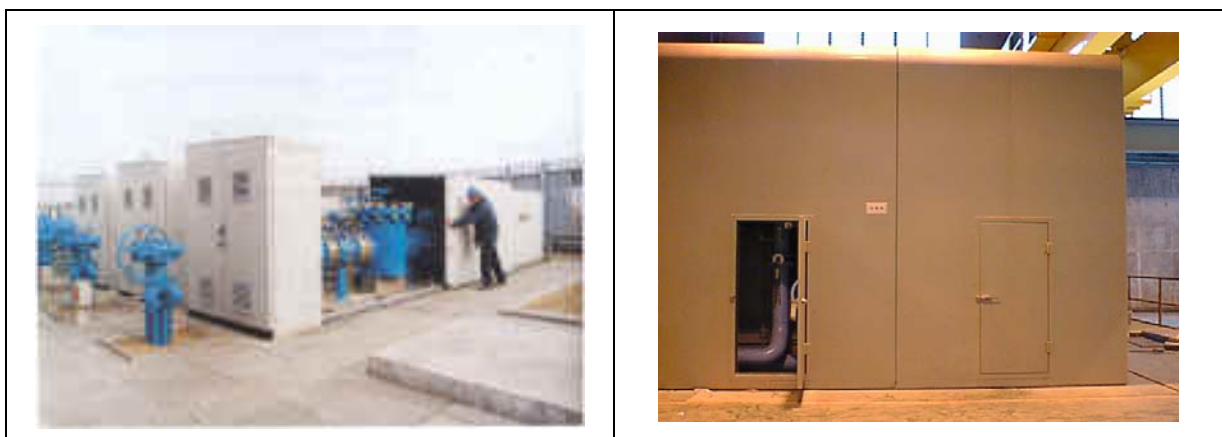
圖 14-3 各種形式隔音罩
