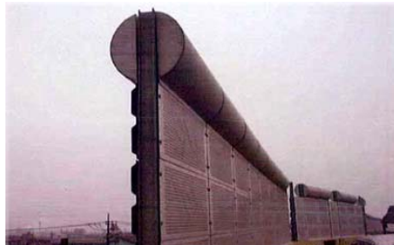
圖 14-6 吸音圓筒示意圖
