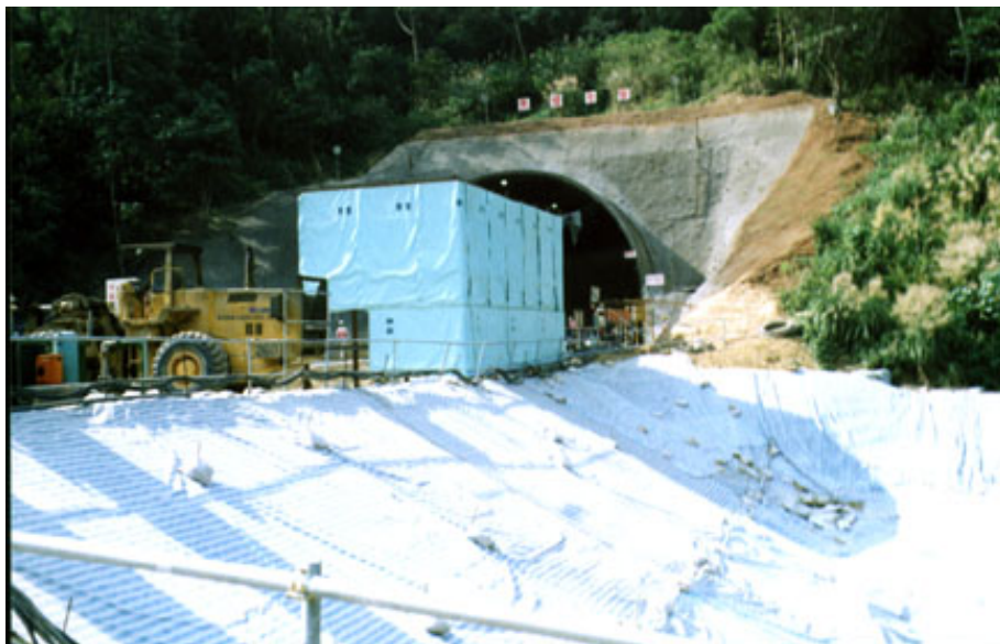
圖 14-7 隧道口「隔音」示意圖
