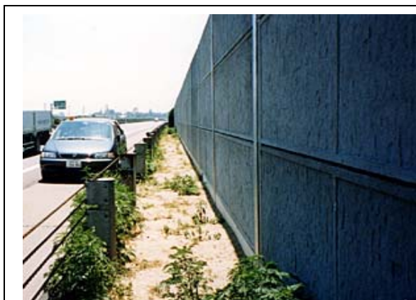
Kazo Expressway ,Tokyo ，大塊混凝土牆
