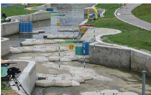
北京奧運激流划船場水道區施工
