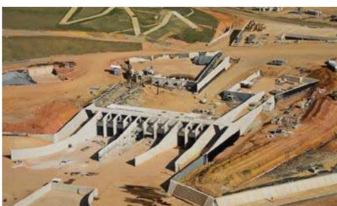
里約奧運激流划船場幫浦區施工
